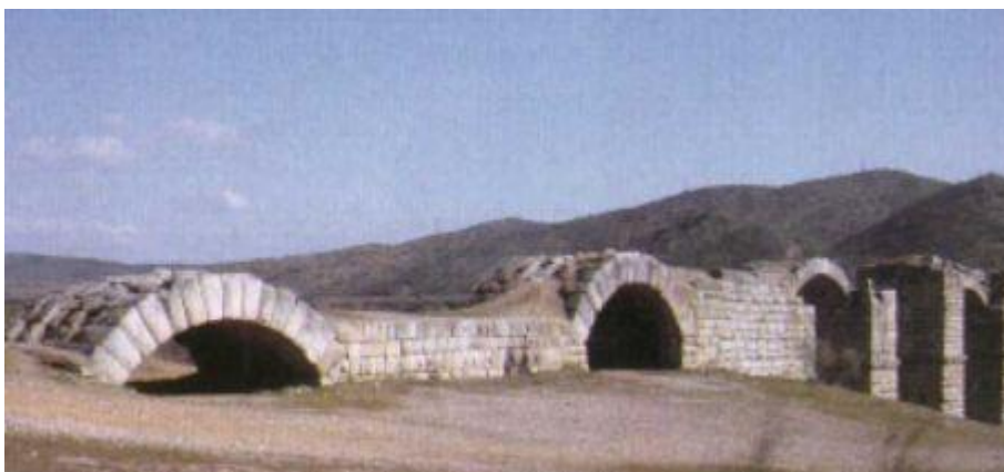
Puente romano de Alconetar, reparado por el Temple, que cobraba peaje por el paso de ganados y vehículos
